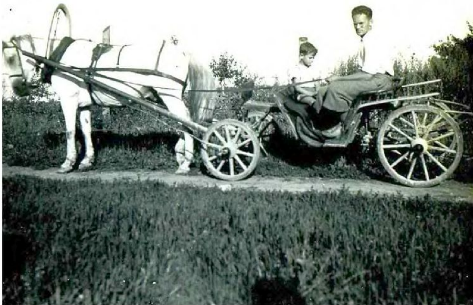
Dojazd ze stacji kolejowej Zemgale, Zdzisław Brodzki i Tomasz Łaszkiewicz
